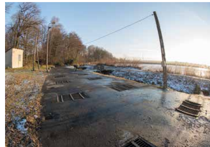
MAGAZYN RYB TO UMIESZCZONA W ZIEMI BETONOWA KONSTRUKCJA , PODZIEMNA NA ODDZIELNE, PRZYDZIELONE POSZCZEGÓLNYM RYBAKOM KOMORY
